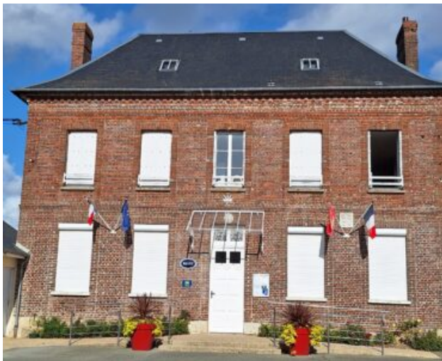
Mairie Après travaux
