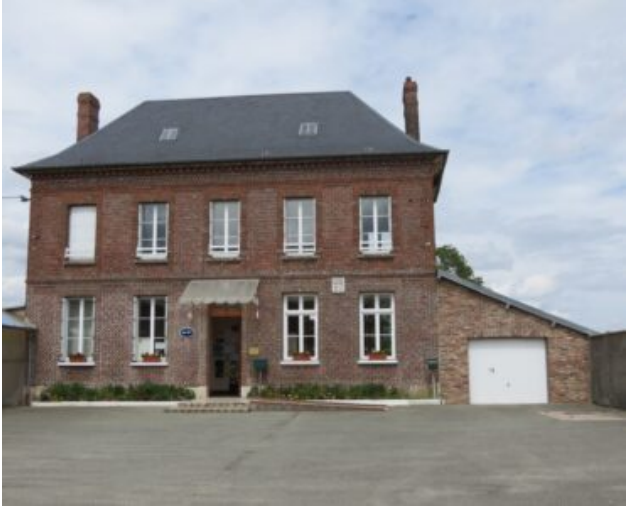
Mairie Avant travaux
