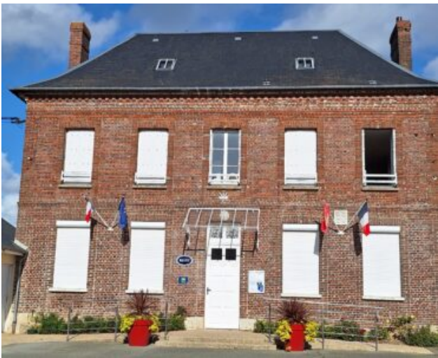
Mairie Après travaux
