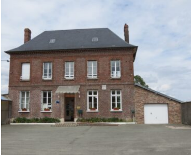
Mairie Avant travaux
